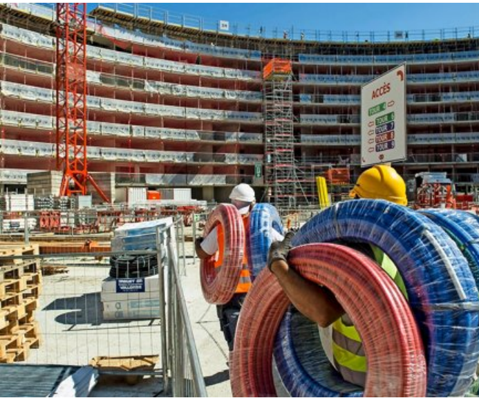
Le Vortex, toujours en construction, sera un lieu central des Jeux olympiques de la jeunesse en 2020. VANESSA CARDOSO
